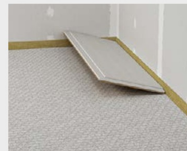
Recouvrir par les plaques de sol fermacell®
